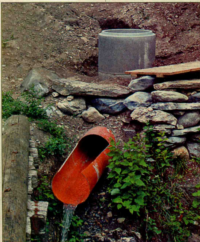
Das kleinste Wasserkraftwerk im Oberwallis.
